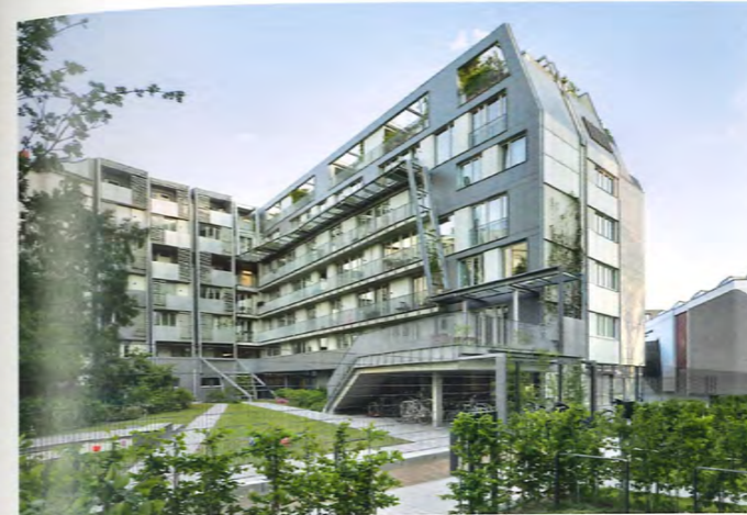
15 Metropolenhaus, Ansicht Besselpark/Gartenfassade
