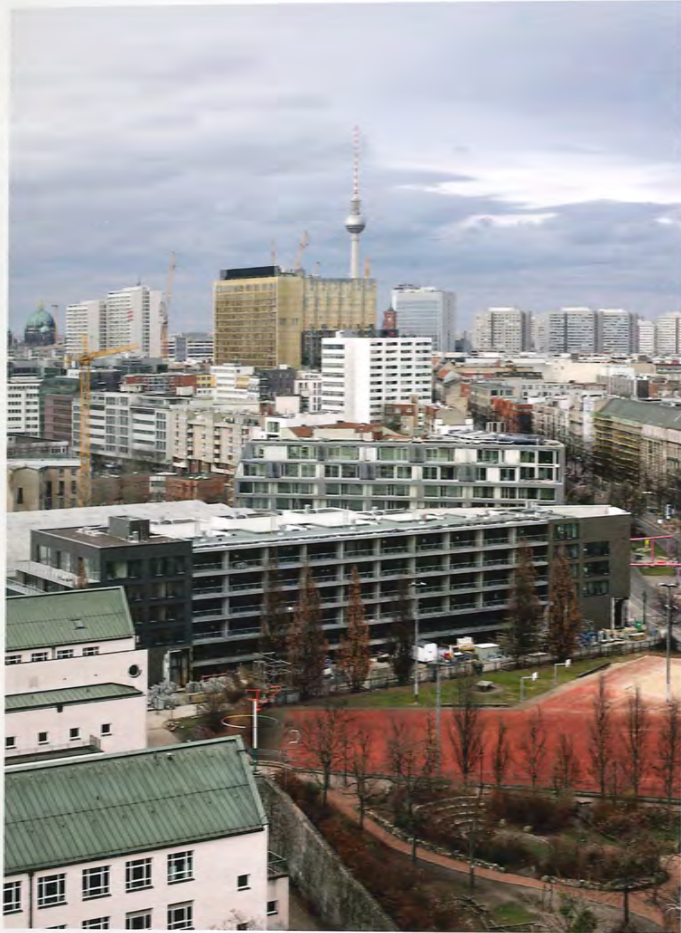
10 Integratives Bauprojekt IBeB, Ansicht von Süden
