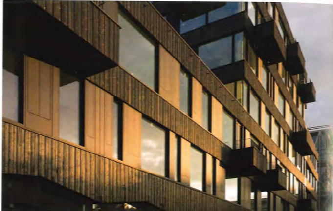
12 FRIZZ23, Fassade zum Besselpark
