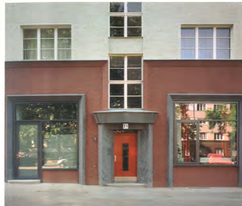
Wiederherstellung der Schaufenster an der Bellermannstraße.
