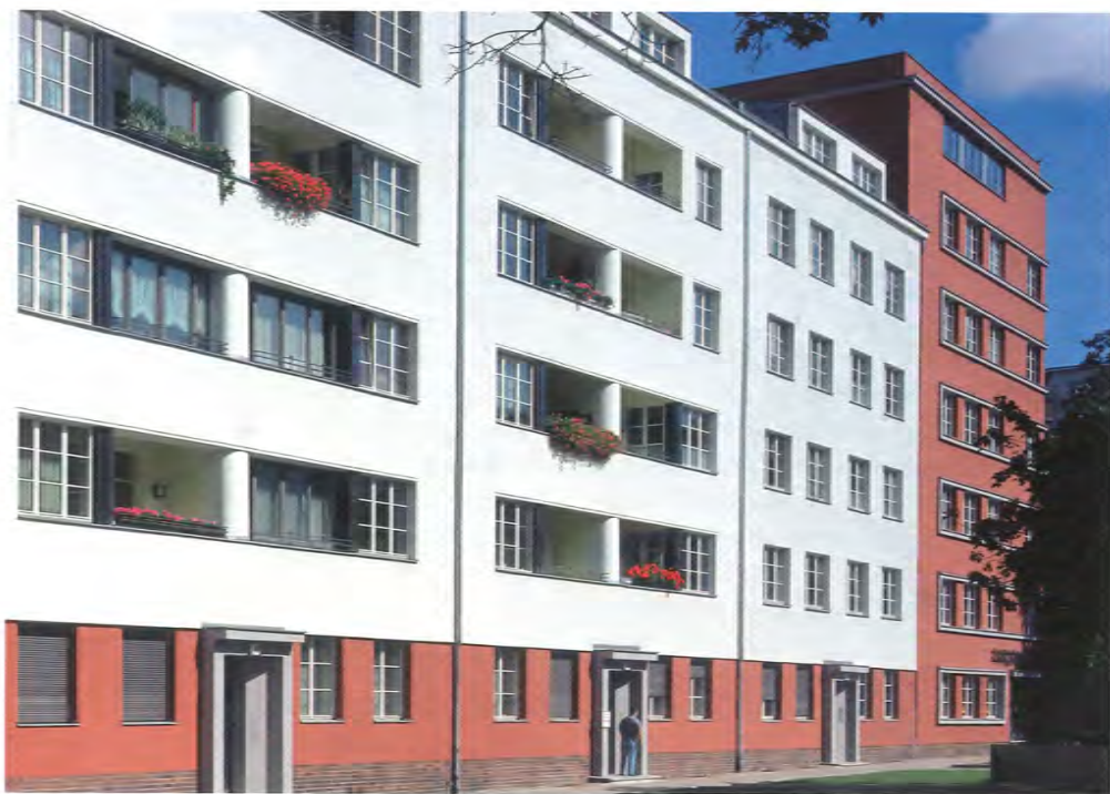
Fassade Behmstraße nach der Sanierung.
